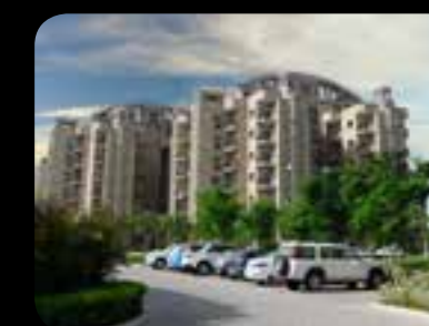
ATS PRELUDE Dera Bassi
